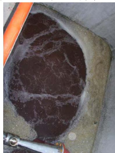
图四 SBR池中的曝气情况
