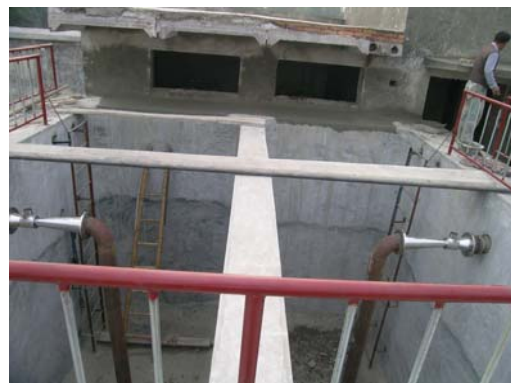
图二 GW800射流器安装在SBR池中
